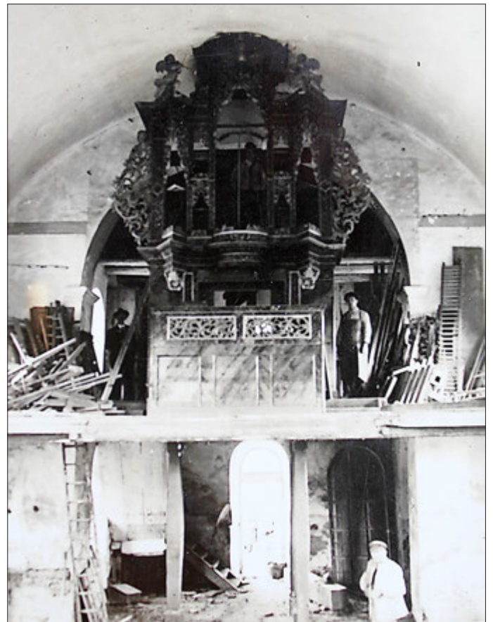
Rückbau der Orgel in der alten Kirche
