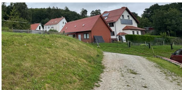
Blick vom vorh. Schotterweg und Zufahrt zum geplanten Bau- platz mit Nachbarbebauung zur städtebaulichen Beurteilung
