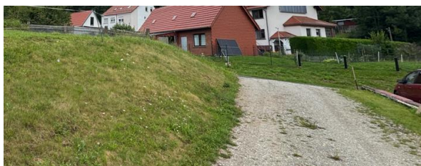
Blick vom derzeitigen Schotterweg und späteren Bauplatz mit erforderlichen Böschungsabtrag für den geplanten Neubau
