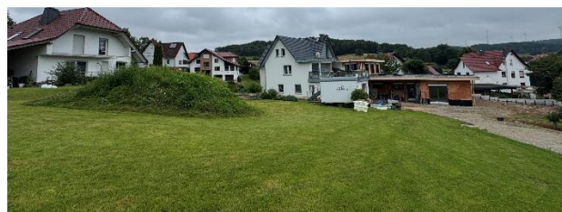
Blick auf die Baustelle an der Dorfstraße mit provisorischer Schotterzufahrt im rückwertigen Bereich
