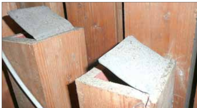
Durch Staub verdeckte Stimbleche der Holzpfeife.
