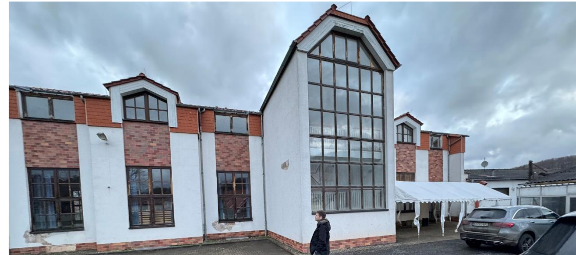
Hofseite vorh. Saal mit Treppenhaus zum ungenutzten Dachgeschoss
